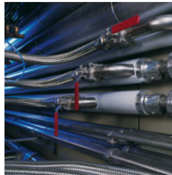
Spannungsfreier Dampfanschluss mit ASSIWELL® Ganzmetallschlauchleitungen Typ 133 DN 40
