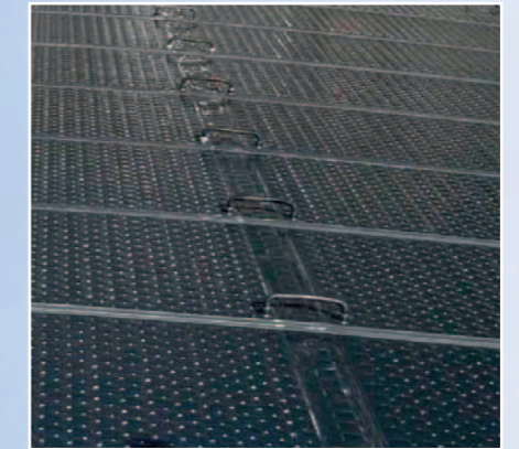
Der APSOfluid® ASSIWELL® Metallschlauch verbindet die Sonnenkollektoren miteinander.
