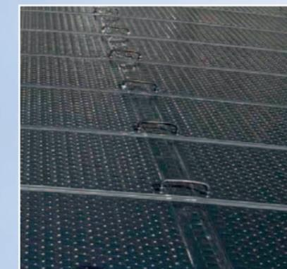
Tubo flessibile in metallo APSOfuid® ASSIWELL®: elemento di collegamento tra due collettori
