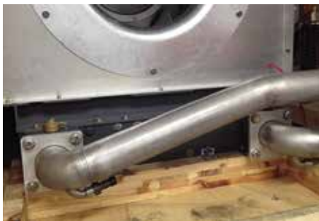
Tubi con raccordo rigido al radiatore.
